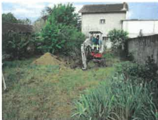
Figure 3 : Vue de l'implantation du sondage S2 parcelle 2025
