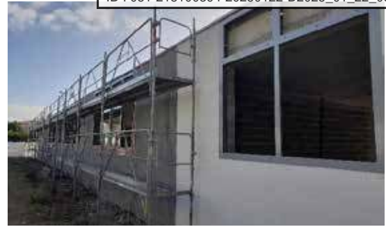
Isolation thermique par l'extérieur
