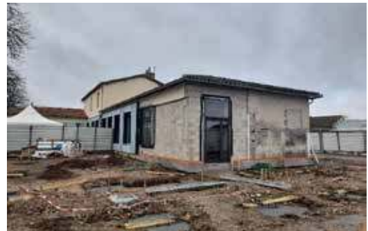
Réalisation des fondations du futur préau
